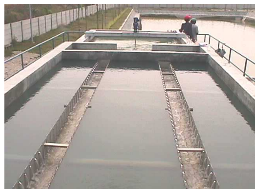
FLOCCULATOR DAN BAK PENGENDAP DENGAN HONEY COMB
